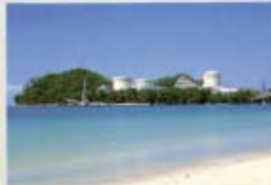
原子力発電所
