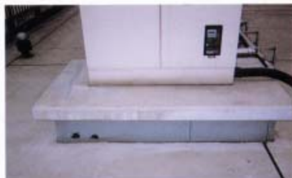
コンクリート基礎施工前
