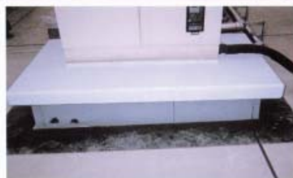
コンクリート基礎施工後
