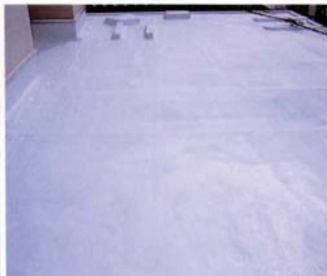
ルーフメイトで施工後のアスファルト防水層
