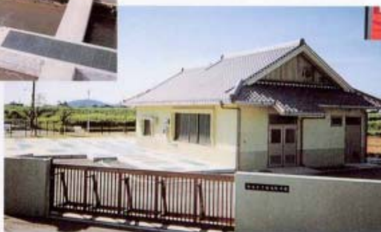
農業集落排水処理施設
