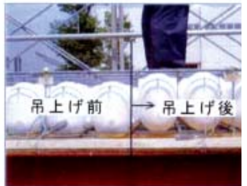
中空材ユニットの吊り上げ
