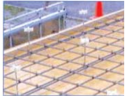
スペーサ取付→下筋設置
