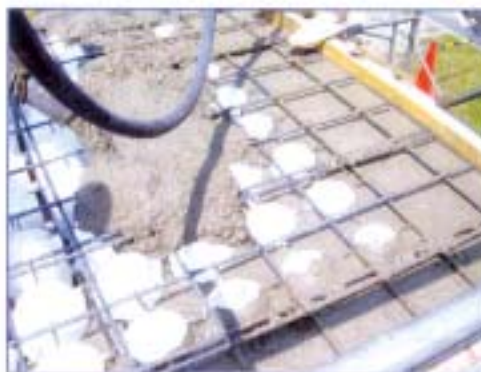
コンクリート打設
